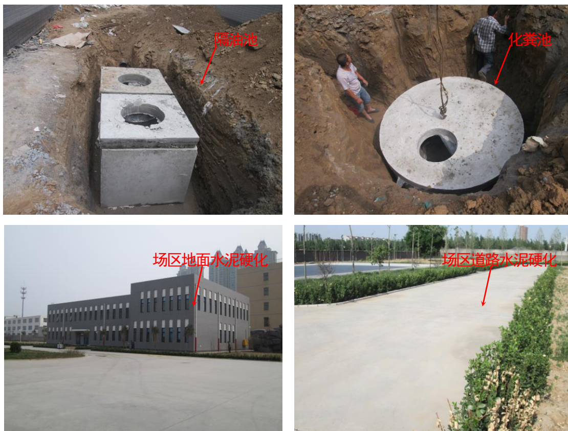
图 3-10 防渗措施现场实施情况
