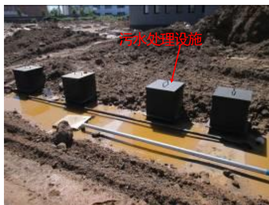
图 3-7 污水处理站现场实施情况
