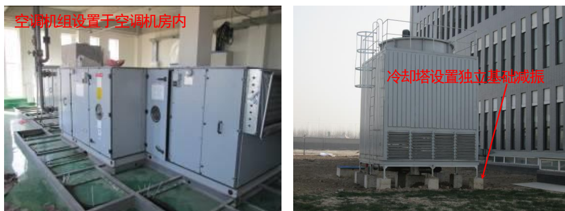
图 3-8 噪声治理措施现场实施情况
